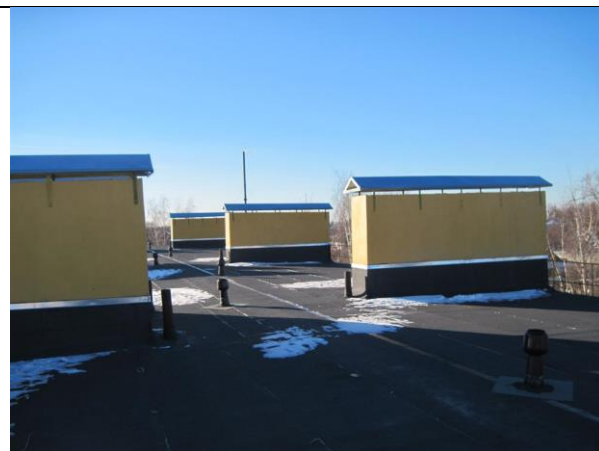
г. Сасово, ул. Октябрьская, д. 47 (Капитальный ремонт кровли)
