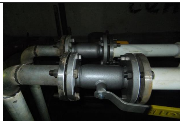
г. Рязань, Касимовское шоссе, д. 36, корп. 1 (Капитальный ремонт внутридомовых систем горячего водоснабжения)
