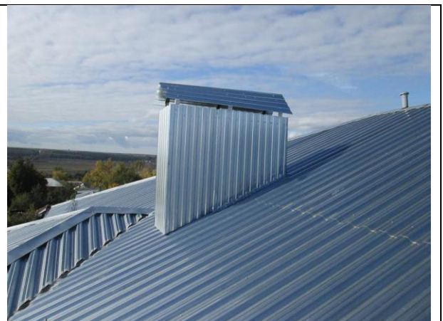
г. Касимов, ул. Дзержинского, д. 10 (Капитальный ремонт кровли)
