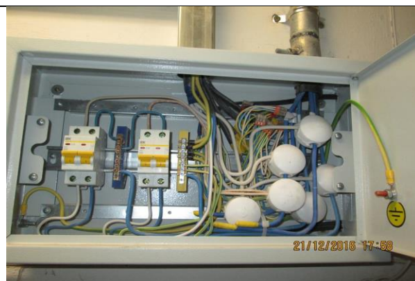
г. Рязань, ул. Вознесенская, д. 51 (Капитальный ремонт внутридомовых систем электроснабжения)
