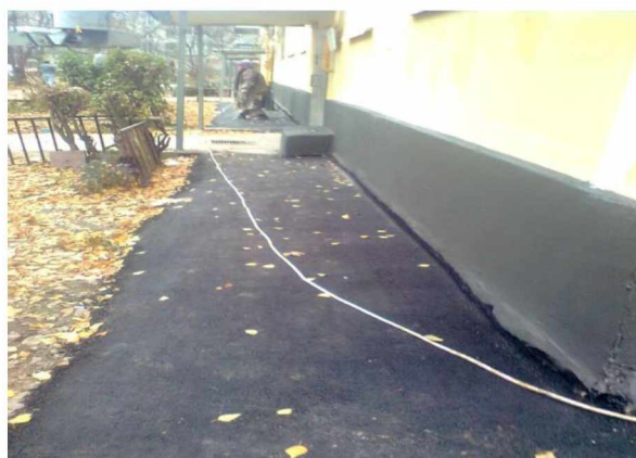
Капитальный ремонт фасада и подвала в многоквартирном доме по адресу: г. Рязань, ул. Фирсова, д. 18
