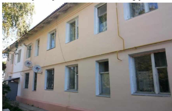
Капитальный ремонт фасада в многоквартирном доме по адресу: Михайловский р-н, п.Горенка, ул.Гагарина, д. 1
