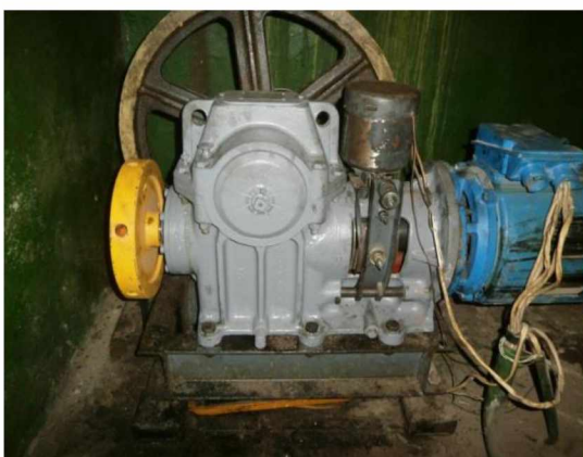
Капитальный ремонт лифтового оборудования (замена редуктора лифтовой лебедки) в многоквартирном доме по адресу: г.Рязань, Московское шоссе, д. 47 кор.1
