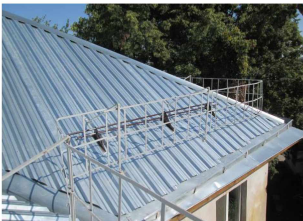
Капитальный ремонт крыши в многоквартирном доме по адресу: г.Рязань, Куйбышевское шоссе, д. 10/2
